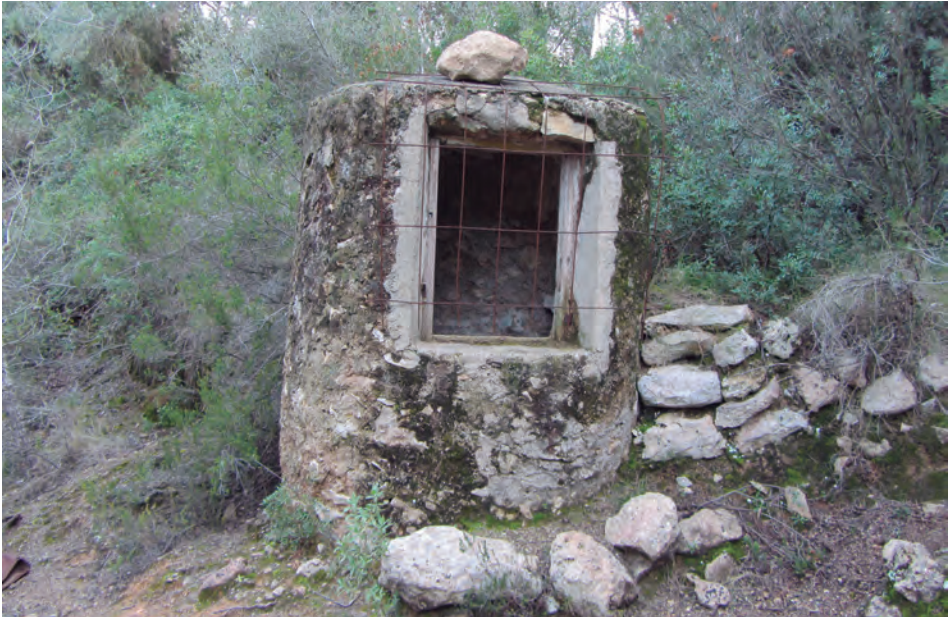
FOTOGRAFIA 13. La cisterna del Maginet de la Carn (autor: X. Martorell).
